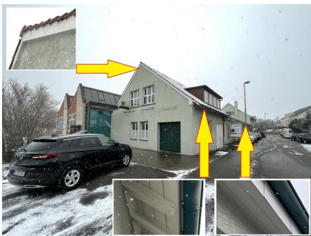
Abb. 2: Blick auf den nordöstlichen Gebäudeteil mit Dachüberstand ohne Nistgelegenheit und Abschlussleiste unter Dach.
