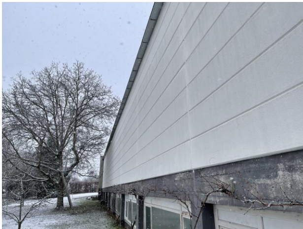
Abb. 6: Südseite des Gebäudekomplexes ohne potentielle Spaltenquartiere zwischen Dach und Außenwand.
