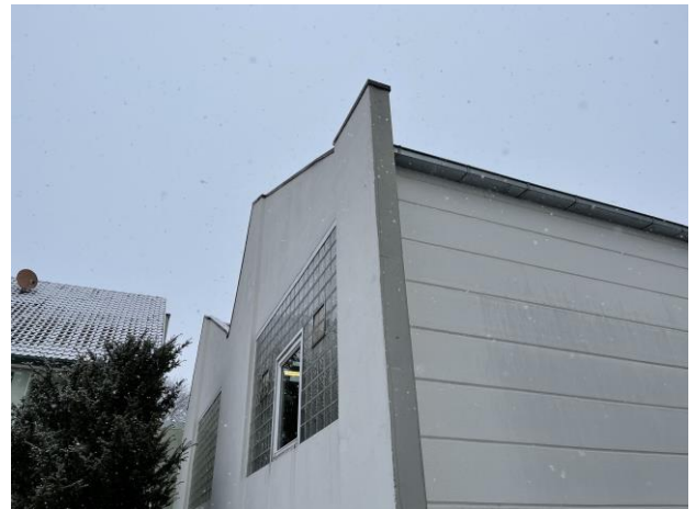
Abb. 7: Südwestseite des Gebäudekomplexes ohne potentielle Spaltenquartiere zwischen Dach und Außenwand.
