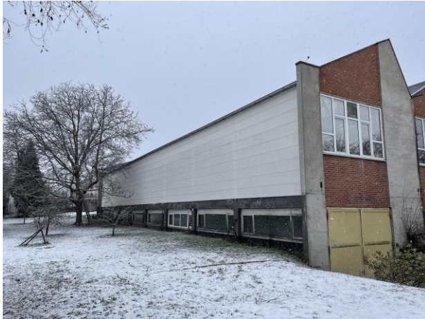
Abb. 4: Südostseite des Gebäudekomplexes ohne potentielle Spaltenquartiere zwischen Dach und Außenwand.
