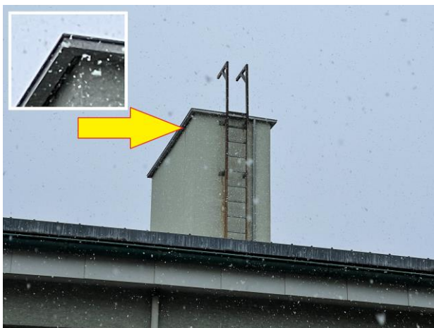
Abb. 8: Turmartiger Aufbau ohne Spaltenquartier unterhalb des Daches.
